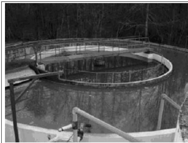
*Photographie d'une petite station d'épuration rurale par boue activée (traitement biologique)*
