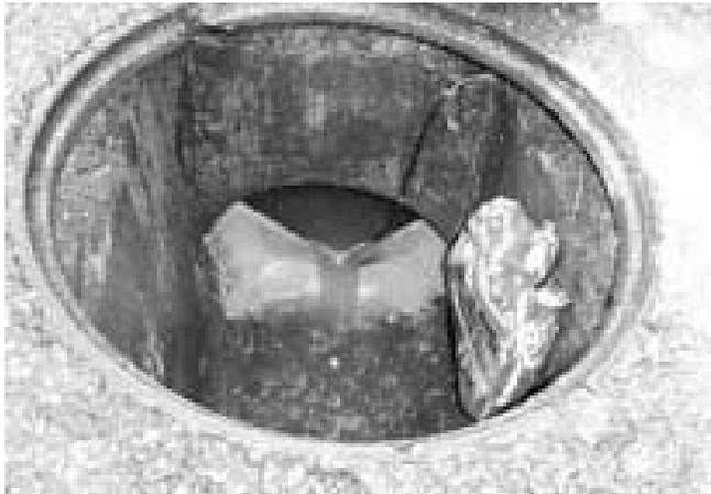
mise en place de débitmètre par seuil et sonde piézométrique
