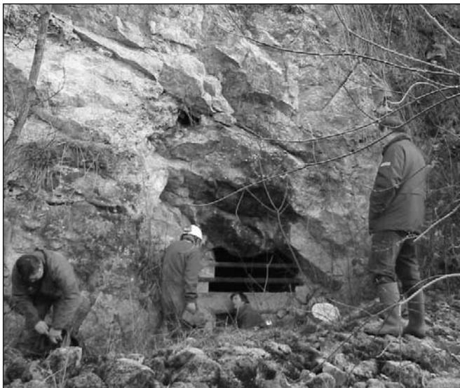
*Les travaux de fermeture du Trou Marique (Mur plein surmonté d'une chiroptière) ont fortement modifié l'entrée de la cavité. L'influence de ce type d'aménagement sur le micro-climat de la cavité peut s'avérer assez critique.*
