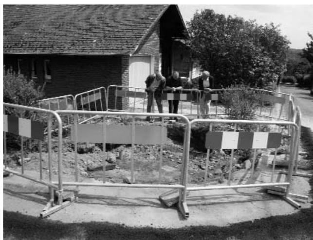
*Effondrement s'étant ouvert brusquement (2003) sur les hauteurs de Bouge (commune et province de Namur) en pleine zone résidentielle. Ce type d'effondrement rappelle et démontre combien la prudence doit être de mise lors de plan d'urbanisation sur substrat calcaire karstifié*
