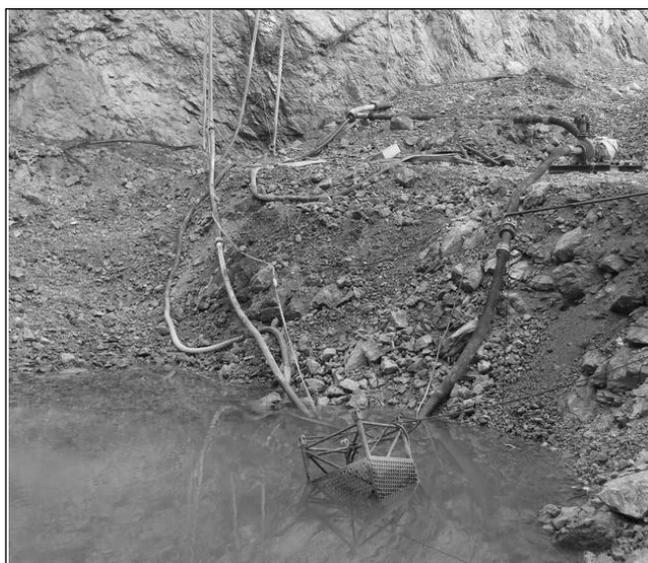
Exhaure dans le fond de la Carrière Berthe à Florennes. Les eaux de la nappe sont remontées sur plus de 80m pour être déversées dans les eaux de surface
