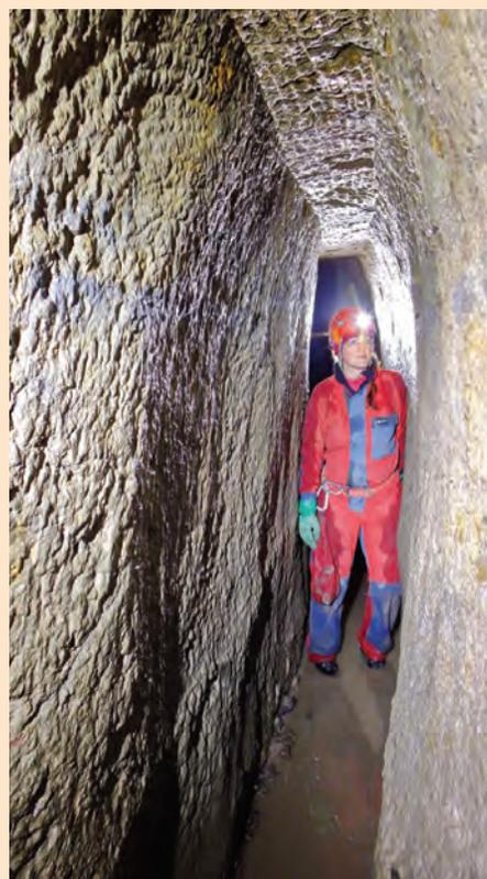
Anciennes mines d'argent taillées dans les gneiss en Alsace. Les traces des outils des mineurs (pointerolles) sont visibles sur l'ensemble des parois et au plafond.
