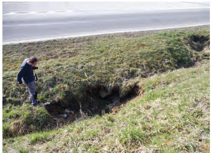
*Effondrements le long de la RN 63 (bretelle d'accès à la voie rapide) sur l'axe supposé des eaux souterraines de Méan (voir site 54/4-11).*
