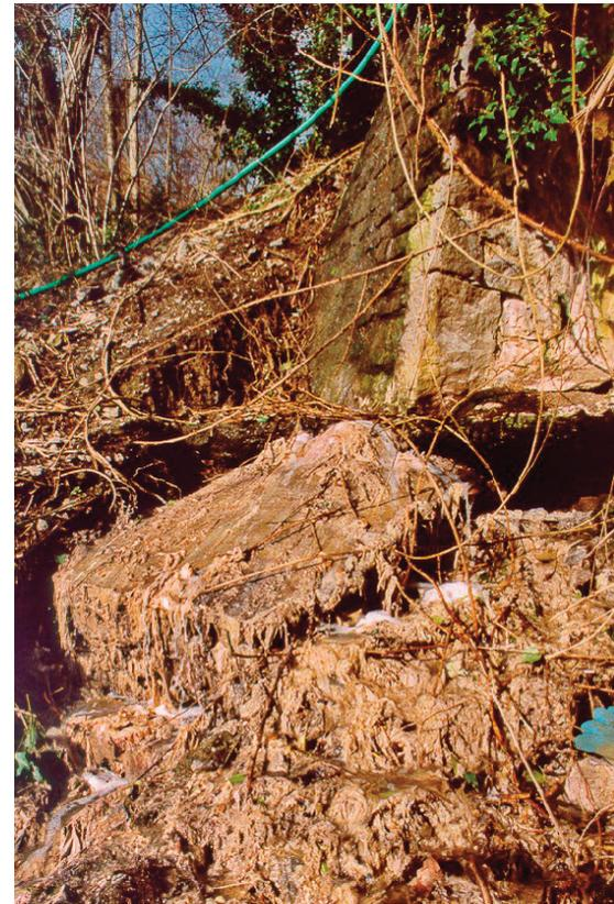
Fig 5. Canalisation fracturée, en contrebas de la route de la Corniche, d'où s'échappent les eaux usées du CHU, le long de la paroi caillasse (photo 2004).
