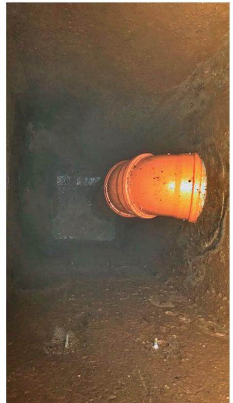
Fig 8. Chambre de visite de la descente des eaux usées du CHU. Un tuyau (orange) oriente directement le flux vers le collecteur sans débordement vers l'aval (photo INASEP - 2018).
