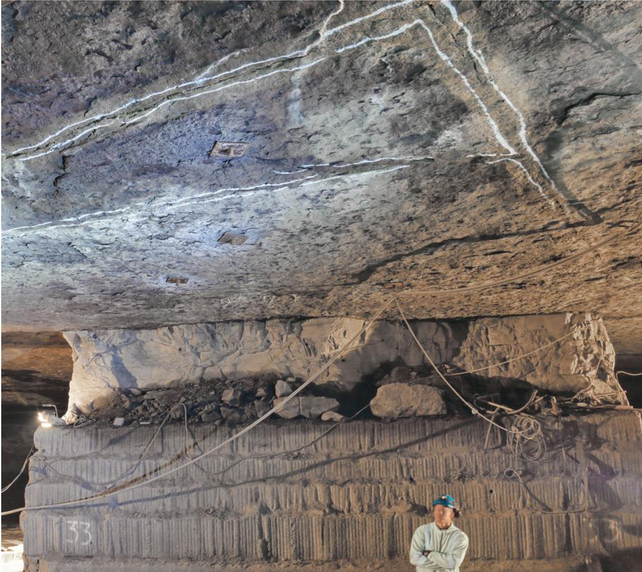
Fig. 6. Marquage de chaque fissure au plafond, avant de clouter les pans de roche pour garantir leur bon ancrage.
