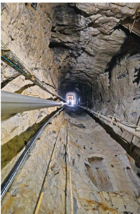
Fig. 5. L'ancien puits d'accès à l'exploitation souterraine (50 m de profondeur) sert aujourd'hui à la ventilation des galeries et à l'évacuation des eaux d'exhaure.
