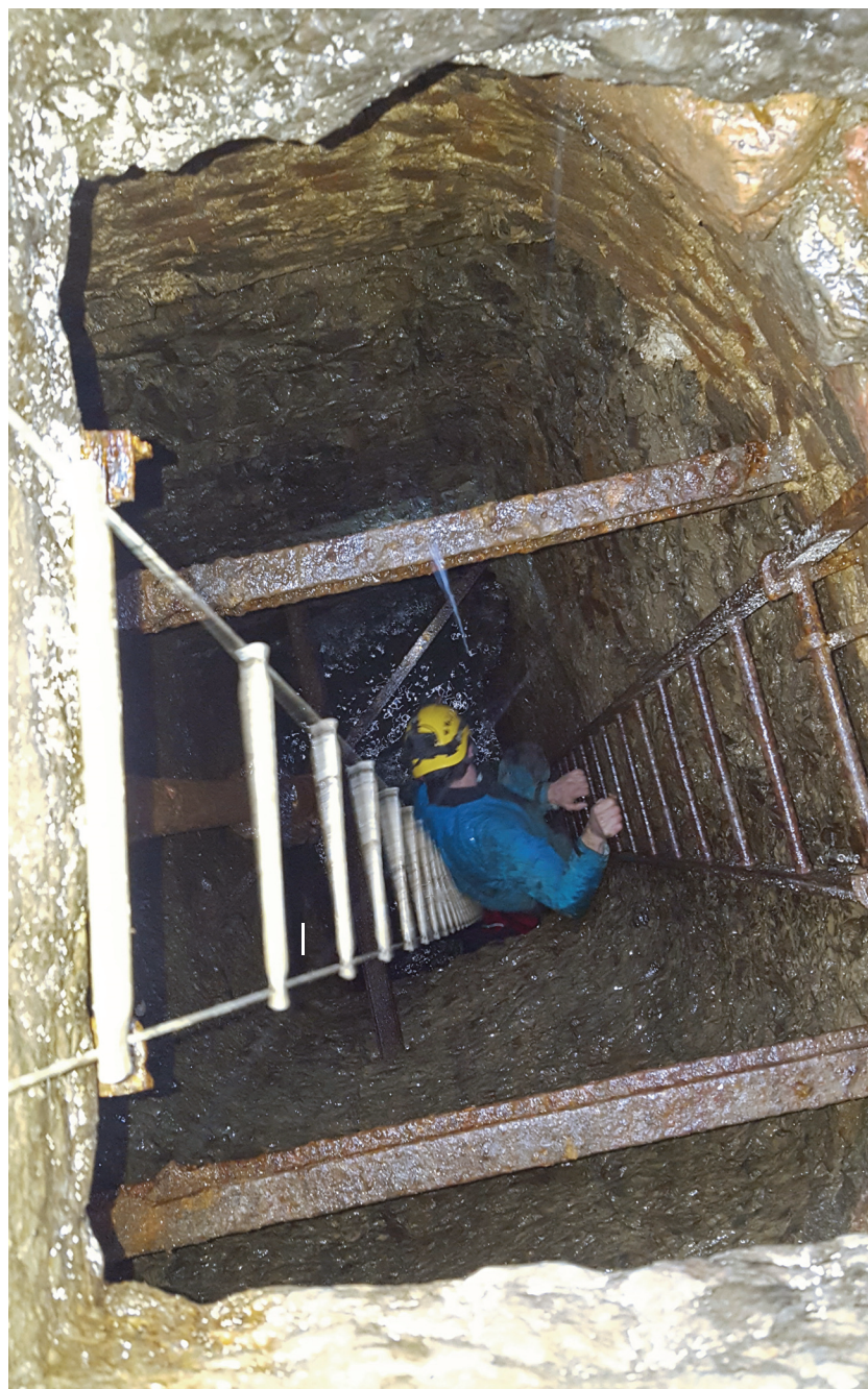
Le puits d'accès à la galerie de drainage, creusé sur 6,5 m, donne accès à un conduit sub-horizontale captant les eaux souterraines (photo D. Pirsoul).
