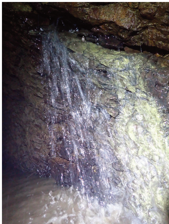
Fig. 10. Venue d'eau bien localisée dans la paroi, contribuant à l'alimentation de la galerie.
