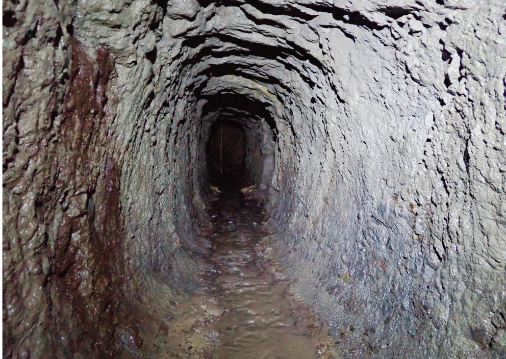
Fig. 4. Conduit amont de la galerie, taillé à la main dans les grès. Les eaux sont drainées vers le puits d'accès (équipé d'une pompe à main) pour ensuite remplir un réservoir à destination de la population.
