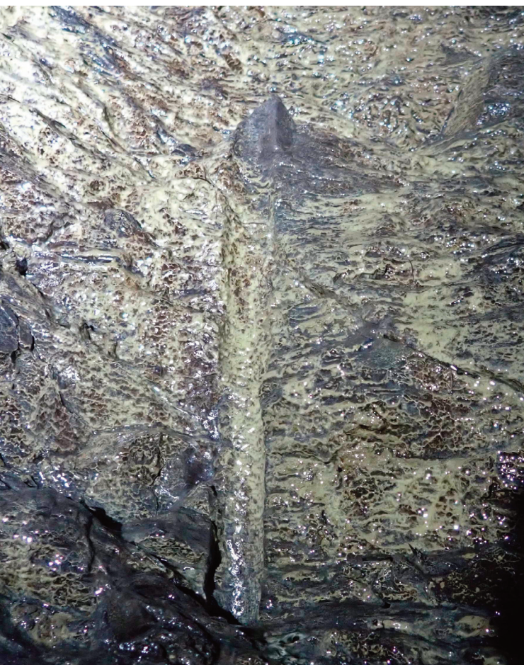
Fig. 7. Traces laissées par les outils sur les parois de la galerie. A gauche, foret vertical dans le puits d'accès; à droite, stries laissées par une aiguille utilisée lors du creusement de la galerie.
