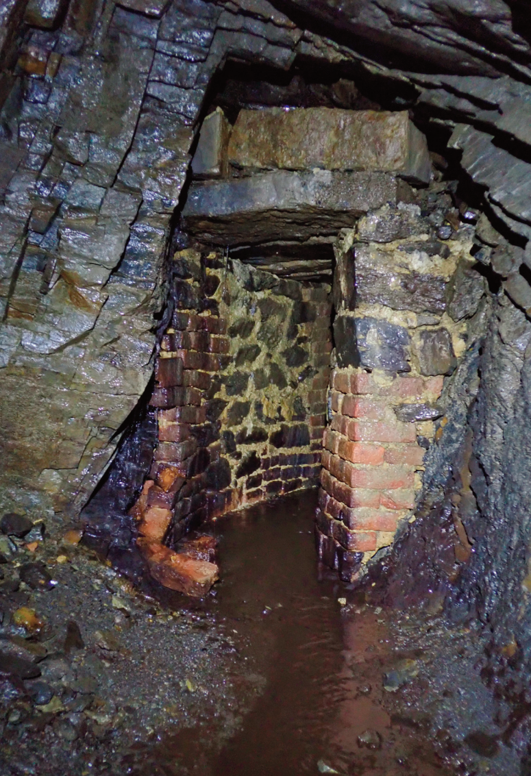
Fig. 14. Des murs de soutènement ont été érigés par endroits pour stabiliser le toit du conduit.
