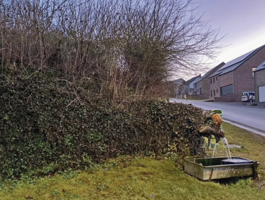
Fig. 6. Vestige des réservoirs (situés dans le bosquet), 150m en aval du puits d'accès de la galerie. Le trop-plein se déverse dans une sorte d'abreuvoir pour ensuite s'écouler vers le centre du village (photo L. Gobeaux).
