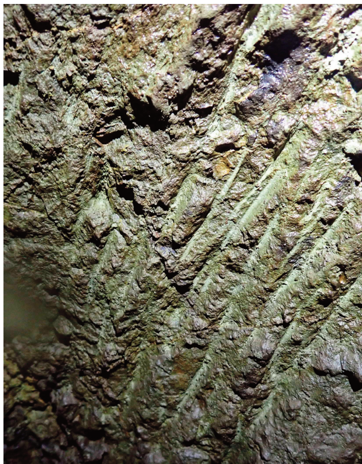
Fig. 7. Traces laissées par les outils sur les parois de la galerie. A gauche, foret vertical dans le puits d'accès; à droite, stries laissées par une aiguille utilisée lors du creusement de la galerie.
