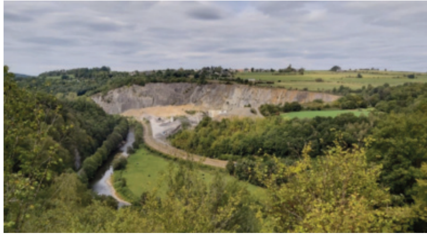
Fig. 1. Le site d'extraction de la Belle Roche en bord de l'Amblève (photo B. de Seille).
