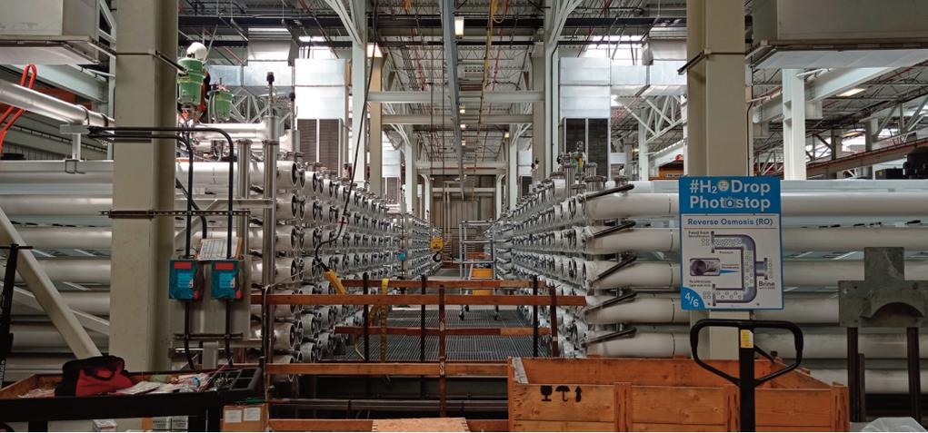
Fig. 3. Une des étapes de traitement des eaux usées par osmose inverse (Reverse Osmosis) de la station d'épuration GWRS d'Orange County (Californie, USA) – Photo Géraldine Picot-Colbeaux
