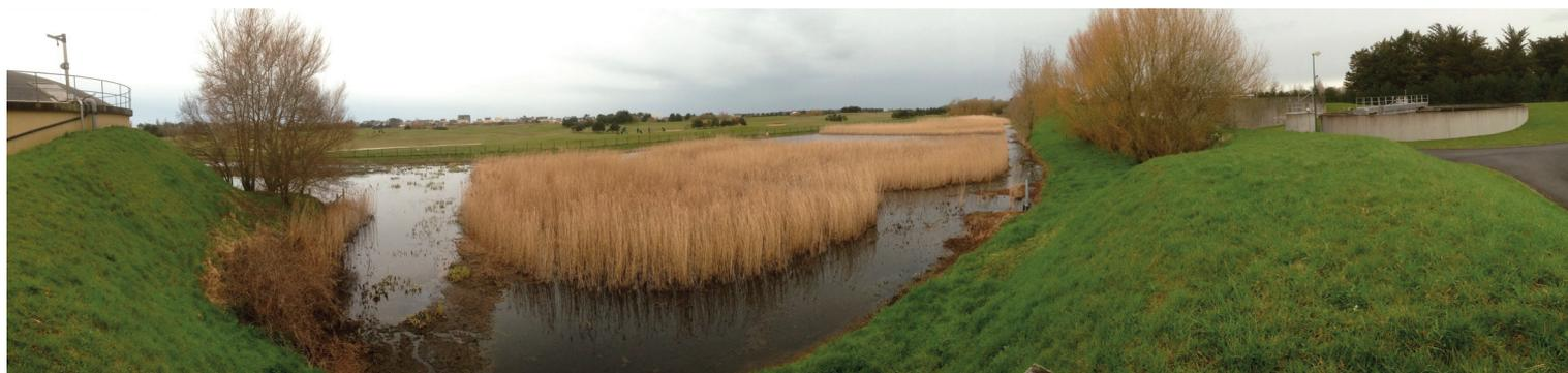
Fig. 6. Dispositif d'infiltration dans l'aquifère dunaire des eaux usées traitées de la station d'épuration la Mare à Jorre d'Agon-Coutainville (France) – Photo Géraldine Picot-Colbeaux.
