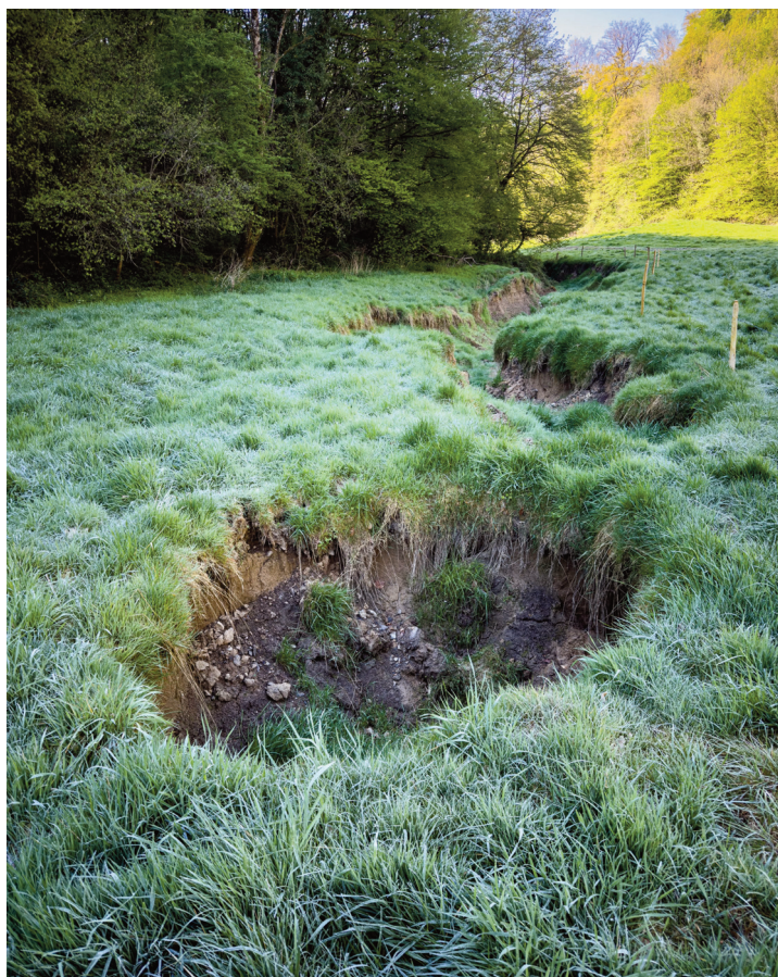
Fig. 4. La zone d'effondrement vue de l'amont. À l'avant-plan, fontis récent, distinct du ravin qui serpente en arrière-plan.
